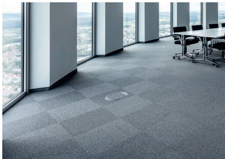
Saubere Lösung, auch bei rundem Grundriss: Den Wandanschluss in den Konferenzräumen bilden gekettelte Teppichsockelleisten, an den bodentiefen Fenstern kam ein passgenauer Anschnitt zum Einsatz.
