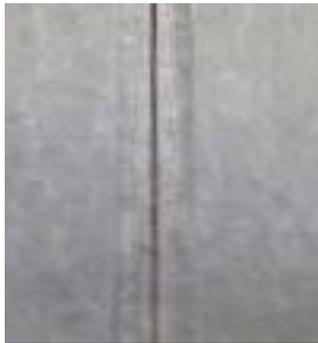
Die Fräsung ist nicht tief genug. Dadurch entsteht keine Haftung zwischen Linoleum & Schmelzdraht.
