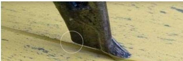
Um sicher zu stellen dass die Verbindung dauerhaft erfolgt, muss der Schmelzdraht richtig geschmolzen werden. Dabei entsteht links und rechts der Fuge ein kleiner Grat bzw. eine Fase:
