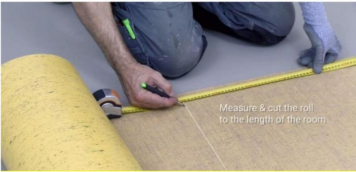
Planen Sie die Einteilung der Bahnen so, dass Nähte nicht im Bereich von Eingangstüren, Hauptverkehrswegen oder Waschbecken angeordnet werden. In einem annähernd quadratischen Raum sollten die Bahnen parallel zum Lichteinfall verlaufen, in langen und eher schmalen Räumen in Längsrichtung.
