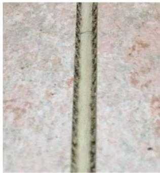
Die Fräsung ist zu tief und der Schmelzdraht kann die gesamte Fugentiefe nicht ausfüllen.
