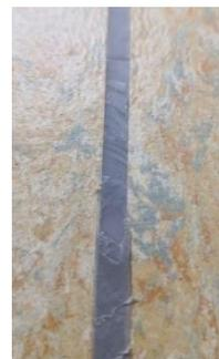
Die Verwendung von ungeschliffenen Klingen führt zu einem schlechten optischen Erscheinungsbild, und einer verstärkten Anschmutzung im Verlauf der Nutzung.
