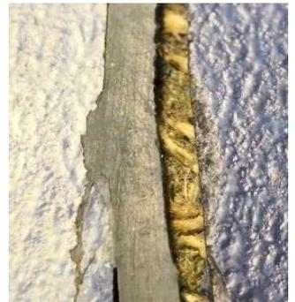
Die Fräsung erfolgt manuell mit einem Messer. Sie ist unregelmäßig und die Jute wird nicht freigelegt.
