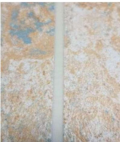
Die Fasern sind auf beiden Seiten sichtbar. Das bedeutet, dass der Schmelzdraht richtig geschmolzen ist (richtige Temperatur & Schweißgeschwindigkeit). Guter optischer Aspekt, gute Haftung zwischen Linoleum und Schmelzdraht
